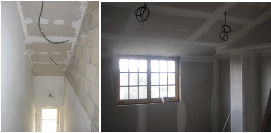
2 e étage : Isolation de toute la toiture terminé !
